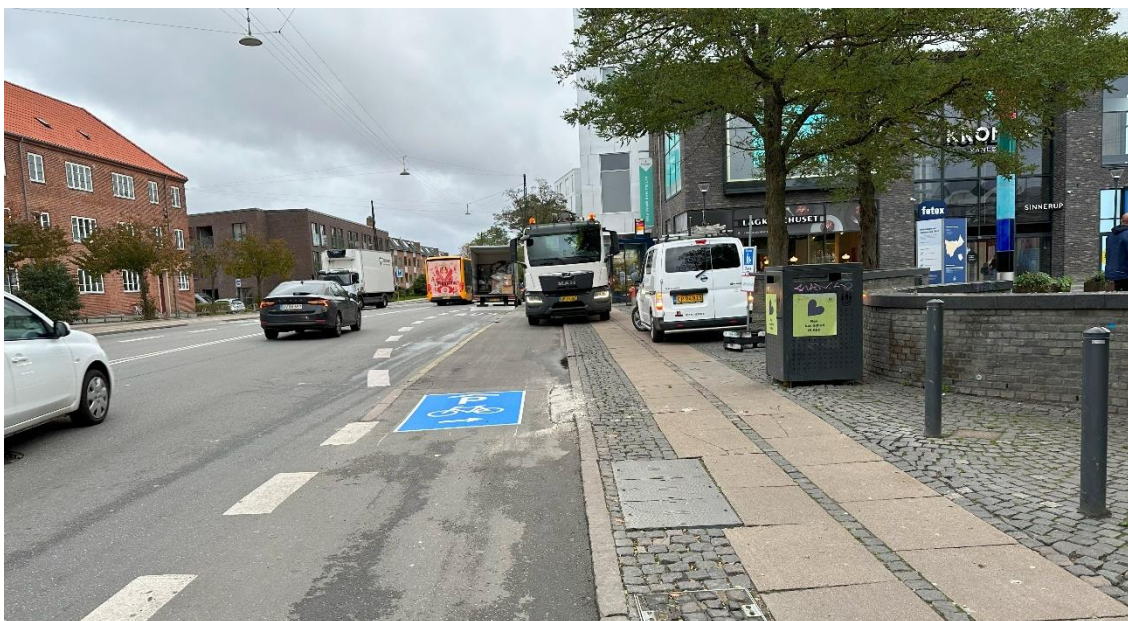
Figur 18 Piktogrammer med henvisning og asfaltrampe mellem cykelsti og fortov, på Vanløse Allé.
