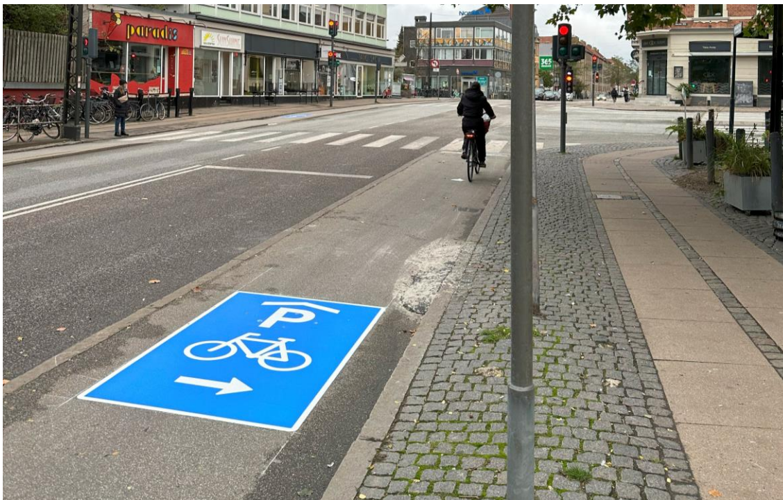
Figur 17 Piktogrammer med henvisning og asfaltrampe mellem cykelsti og fortov, på Jernbane Allé.
